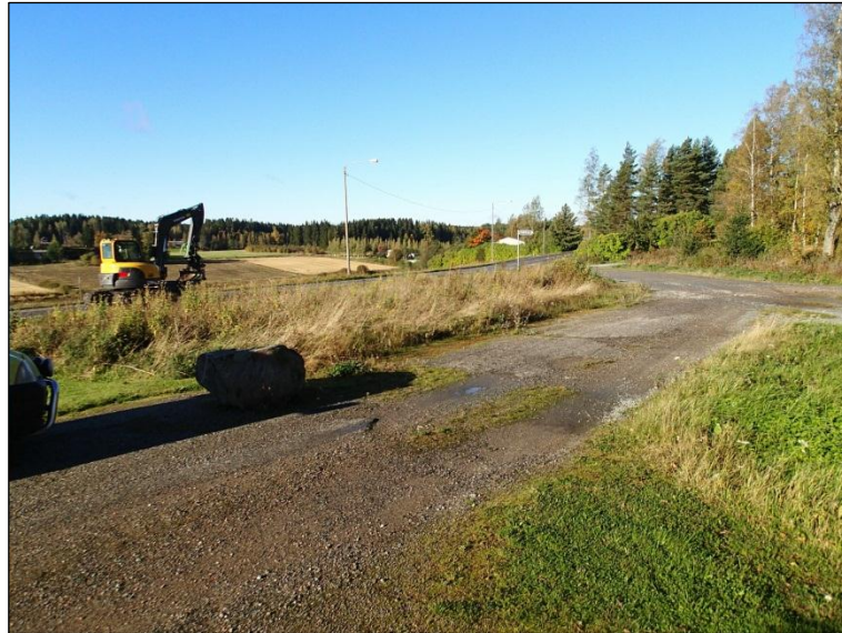
Parrila. Tielinja oli kaivettu auki aiemmin, ilmeisesti vanhan viemäriinjauksen yhteydessä
