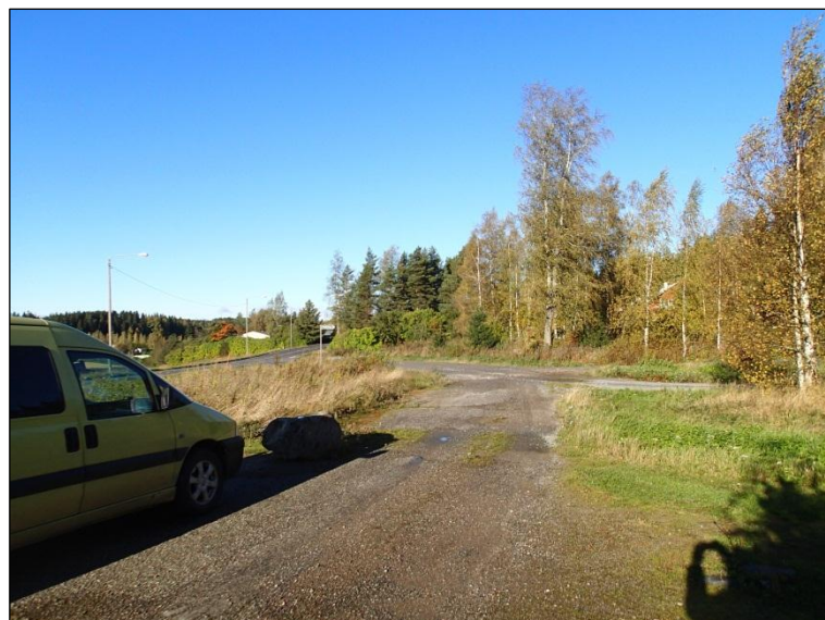
Parrila, vanha tielinja ennen kaivamista.
