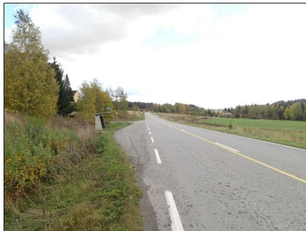
Korrinkoski. Nykyinen ja vanha tielinjaus, vanha hiekkatie nykyisen maantien oikealla puolella.
