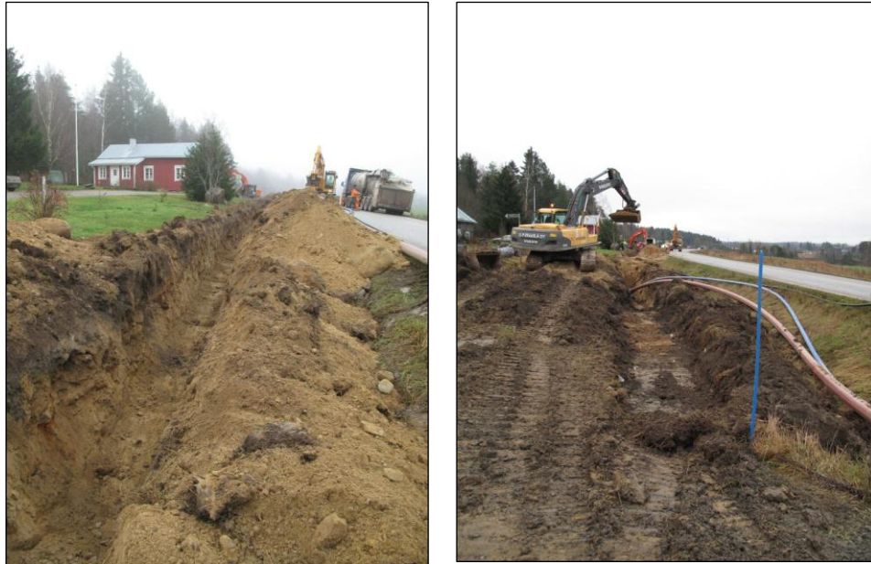
Parrila. Arkeologin valvonnassa kaivettua viemäriinjausta historiallisen kylätontin poikki.
